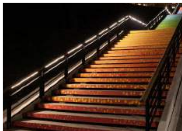
Илл. 4.1.18. ОБОРУДОВАНИЕ ДЛЯ ОСВЕЩЕНИЯ ОГРАЖДЕНИЙ И ЛЕСТНИЦ
