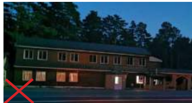
Недопустимо в темное время суток не предусматривать освещение площадки перед объектом ОДС, а также вывески.
