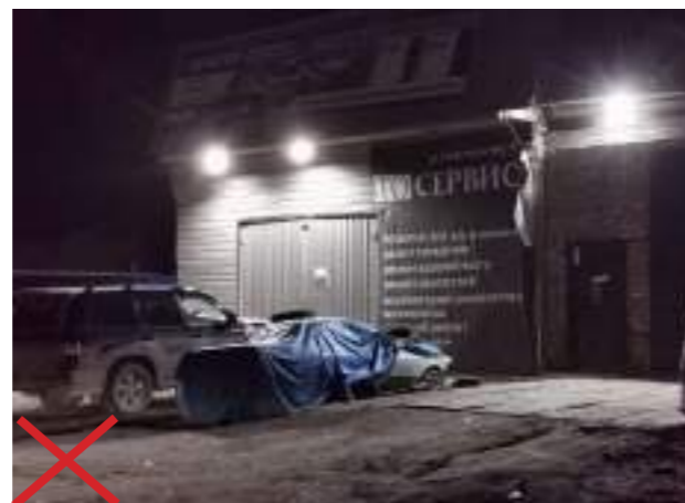
Недопустимо устанавливать светильники (прожекторы) со слепящим эффектом.
